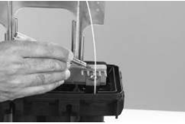
4.11.4 För kabel/kablar genom förseglingen. Märk och avmantla >1500 mm vid KTU-hållarens överkant. Se till att fibrer/tuber inte skadas. Största kabeldiameter som kan monteras i mini-KTU är 2,1 mm.
