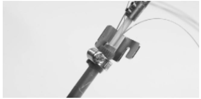
4.8.8 Det separata mantelfixeringsbeslaget lossas och kabelmanteln fixeras med skruvklämma mot T-profilen. Skruven placeras på motsatt sida av T-profilen i förhållande till kabeln skruvskallen vänd åt den del som ligger an mot U-järnet i skarvboxen. (Se bilder.) Mantelfixeringen skall enbart förhindra vridning. Tänk på att inte spänna för hårt så att fiberband/ tuber/fibrer kläms!
