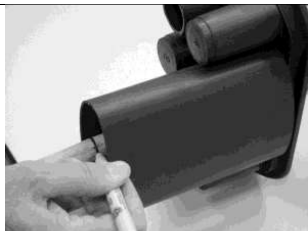
Rimuovere il sacchetto plastico dall'interno della guaina, spingerla fino alla base della muffola e segnare il cavo a filo guaina. Assicurarsi che la guaina sia a battuta contro la base.
