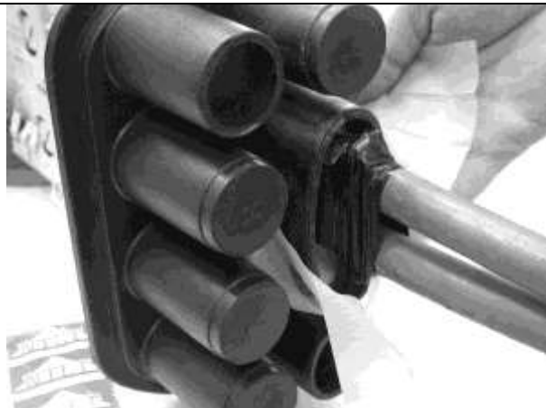
Pulire l'imbocco utilizzando i fazzoletti pre-imregnati.
