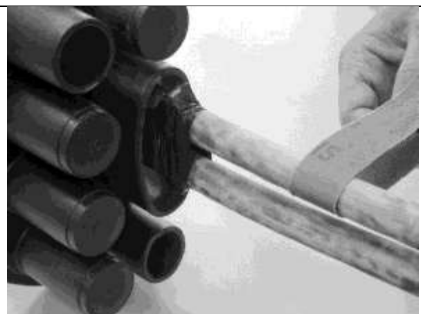
Pulire ed abradere il cavo.
