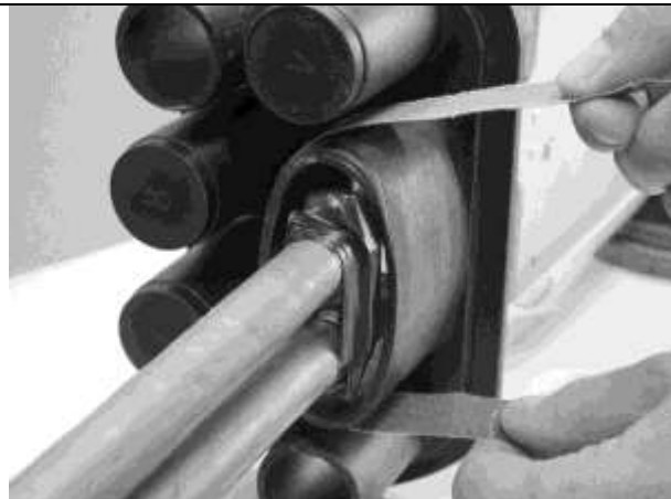
Abradere l'imbocco ovale.
