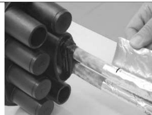
Far combaciare il segno sul foglio d'alluminio con quello sul cavo. Avvolgere il foglio d'alluminio attorno al cavo.
